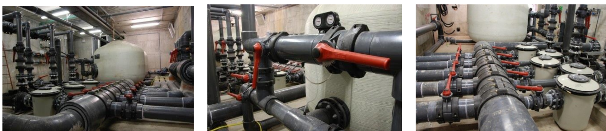
Castiglione delle Stiviere MN Piscina olimpionica Rifacimento impianto
